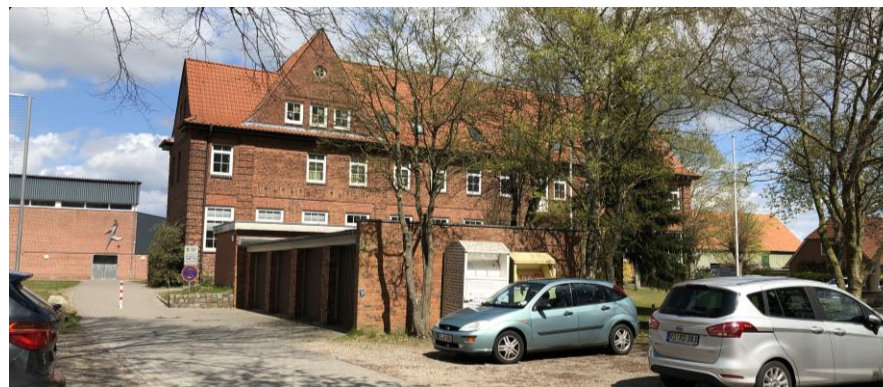
Abbildung 22: Altes Schulgebäude mit der Turnhalle (CIMA 2021)
